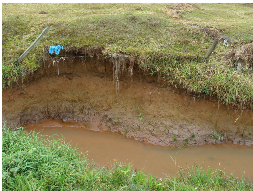
Figura 37 – Queda da terra na margem do rio Pardo destruída, e acúmulo de detritos no arame da cerca que outrora havia no local.
