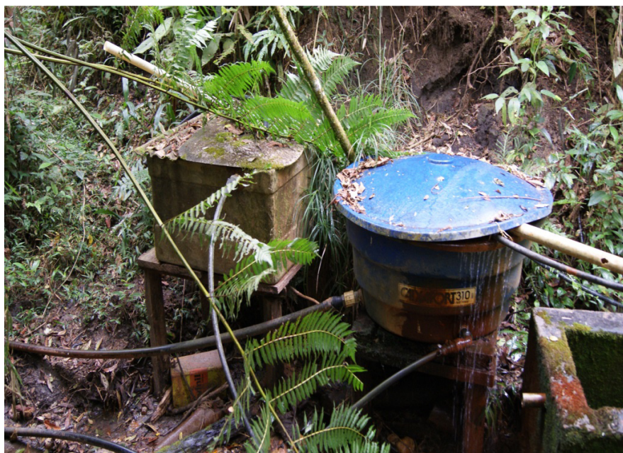
Figura 34 – Caixas d'água para armazenamento da água da primeira nascente do rio Pardo.
